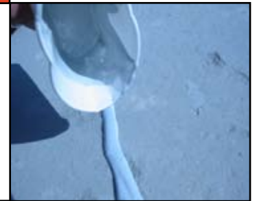
Pour Epothane Into Crack
